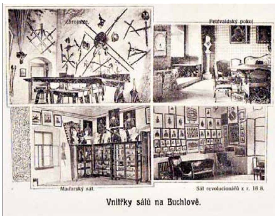
Obr. 14: Buchlov, pohled do zpřístupněných interiérů hradu o 19. století (archiv autora).
